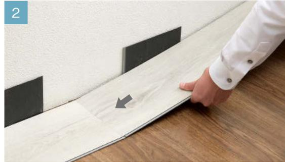
2 一枚目の短辺の実に向かって、二枚目の短辺の実を斜めに差し込み、水平にします。実の継手部分がフラットになっていることを確認します。
