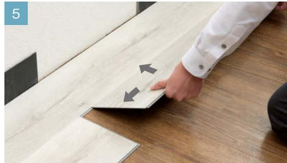
5 一列目の長辺のメス実に向かって、二列目の二枚目のオス実を斜めに差し込み、二列目の一枚目の短辺の実にスライドして、はめ込みます。
