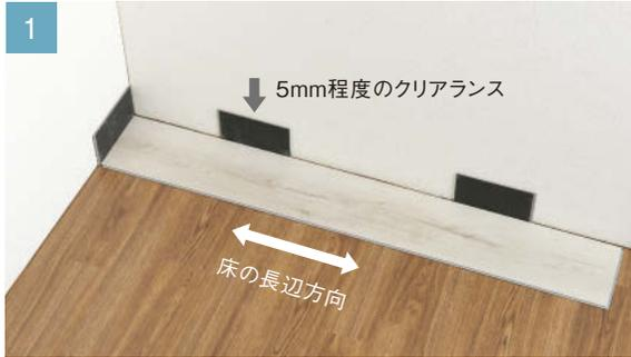
1 施工場所が水平であることを確認します。部屋の長辺方向に、左角から一枚目を置きます。オス実を壁面に向けます。壁面から約5mmのクリアランスを設けます。
