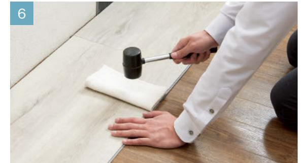
6 実にはめ込んだら、実の継手部分がフラットになっていることを確認します。フラットになっていない場合、実の継手部分にあて布を当てて、ゴムハンマーで軽く叩いてください。強く叩きすぎると、実部分が破損する恐れがあります。
