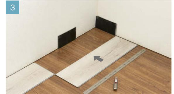
3 2を繰り返します。一列目の最後の一枚は長さをカットして、調整します。
